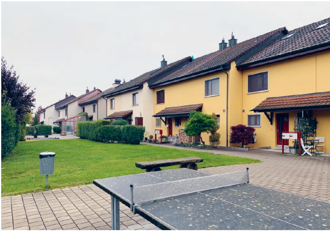
Die zentrale Heizungs- lösung von Meier Tobler versorgt insgesamt 33 Einfamilienhäuser mit Raumwärme.
